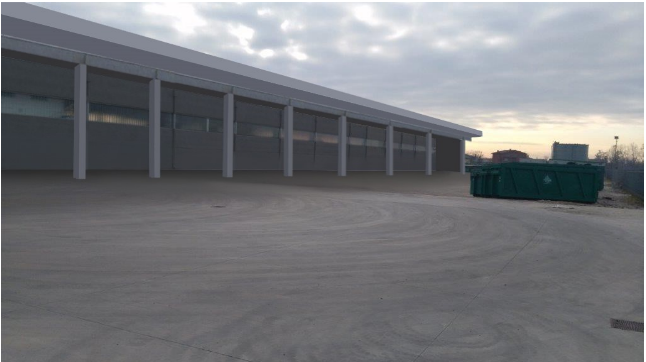
2 - Foto Vista ovest
